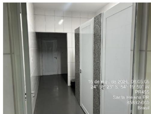
Foto 10 – Salas existentes adaptadas para sanitários
