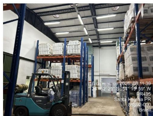
Foto 26 - Fabrica (cobertura/iluminação reformadas)
