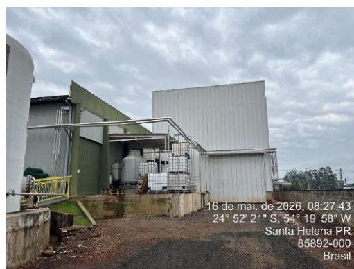
Foto 32 - Fachada Fundos Fabrica (local da casa de maquinas que foi demolida para ampliação do galpão)
