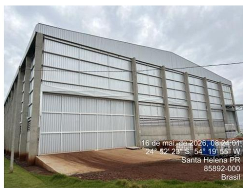
Foto 42- Ampliação da estrutura (galpão construído pela empresa) – não incluso no calculo das benfeitorias
