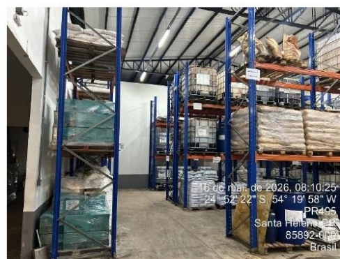
Foto 24- Fabrica (cobertura/iluminação reformadas)
