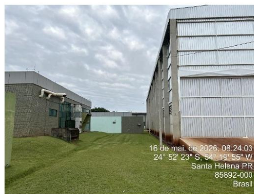
Foto 36 - Fachada Fundos - Ampliação do galpão (à direita) e deposito cozinha (à esquerda)
