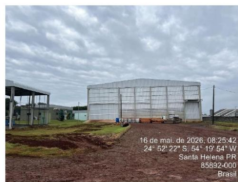
Foto 30 - Area pavimentada que foi usada parcialmente para construção da ampliação galpão feito pela empresa
