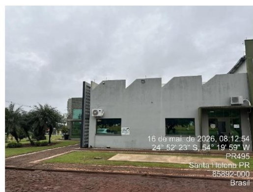
Foto 28- Fachada Lateral Deposito/cozinha
