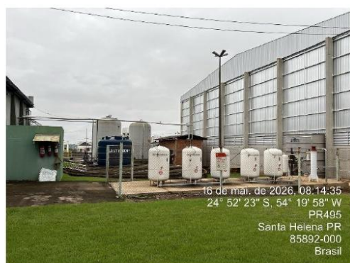
Foto 29- Area de gás (local dos silos retirados)
