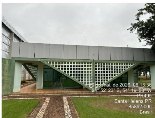
Foto 15- Fachada Frontal Deposito/cozinha
