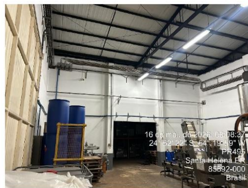
Foto 20 - Fabrica (cobertura/iluminação reformadas)
