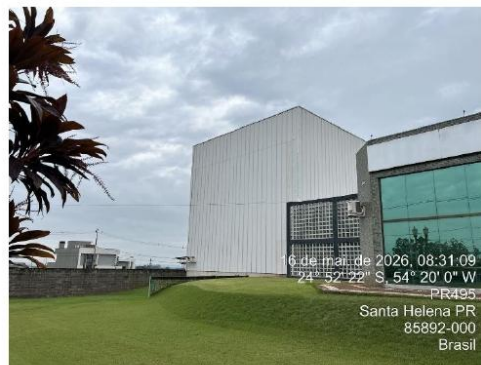
Foto 02 – Fachada Lateral -vista parcial do galpão original (à direita) e vista parcial da ampliação do galpão feita pela empresa (à esquerda)
