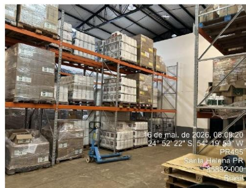
Foto 22- Fabrica (cobertura/iluminação reformadas)
